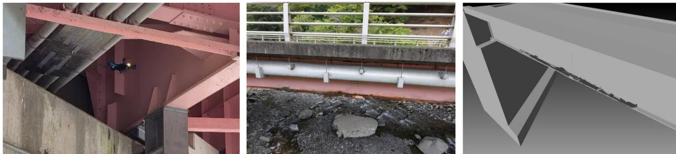
橋梁をUAVで撮影，そしてAIとStructure from Motion (SfM)により3次元モデルに損傷を自動プロット
